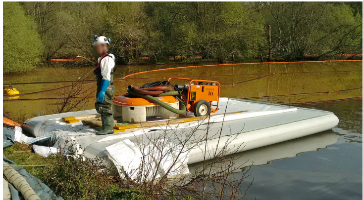
(b) Floating decontamination platform. (© Écocréation)
